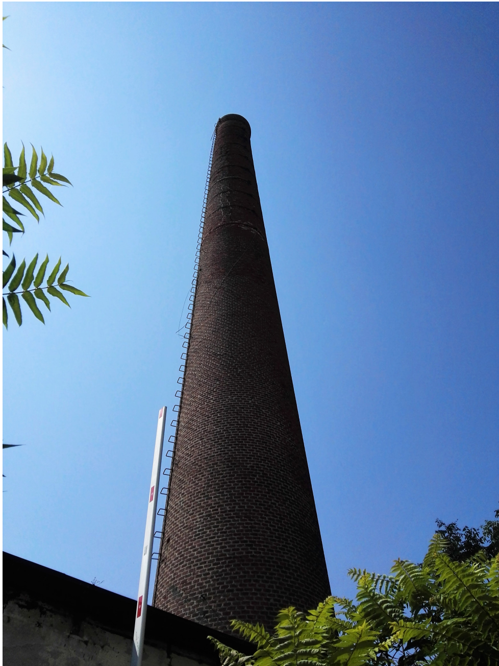
VISTA CIMINIERA LATO N-E
